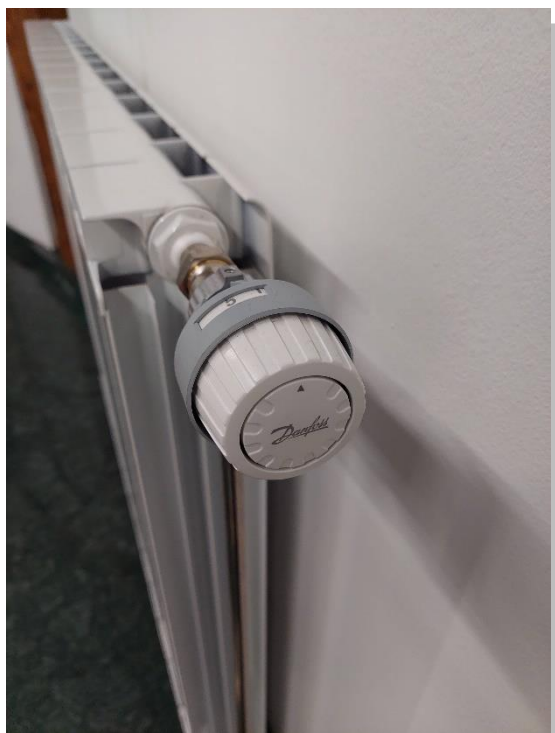
Novi ventili s termostatskimi glavami (foto: Alfonz Zavrnik)
